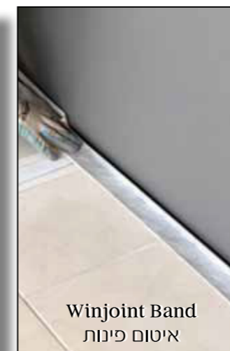
BC Seal Band איטום חיבור קיר-רצפה
